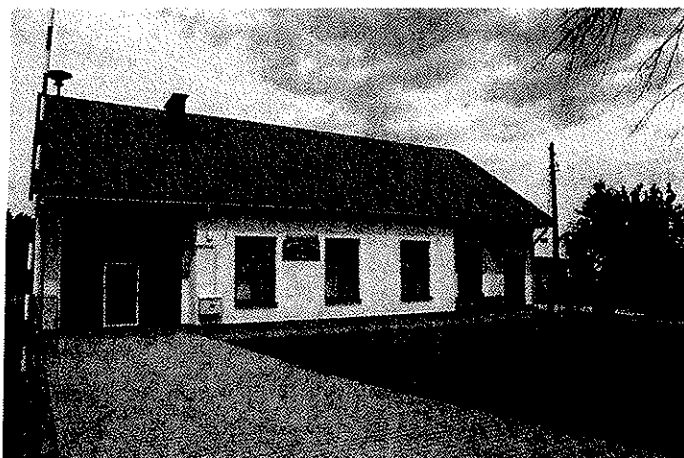
Remiza Ochotniczej Straży Pożarnej w Brzeźnicy
